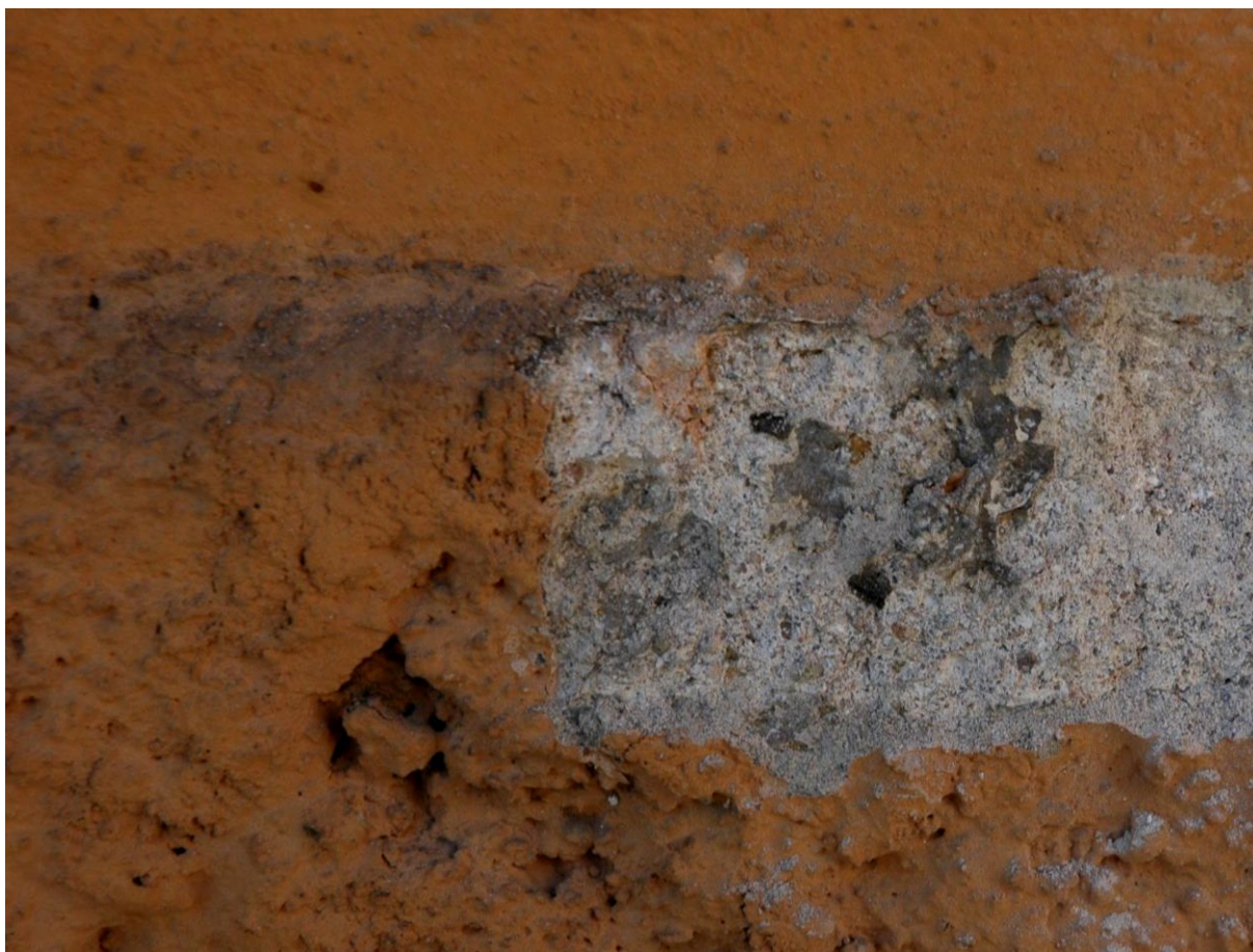
Detail místa odběru vzorku B. V hloubce strukturovaného povrchu omítky (světle šedé barvy) jsou patrné fragmenty fasádního nátěru šedé barvy.
