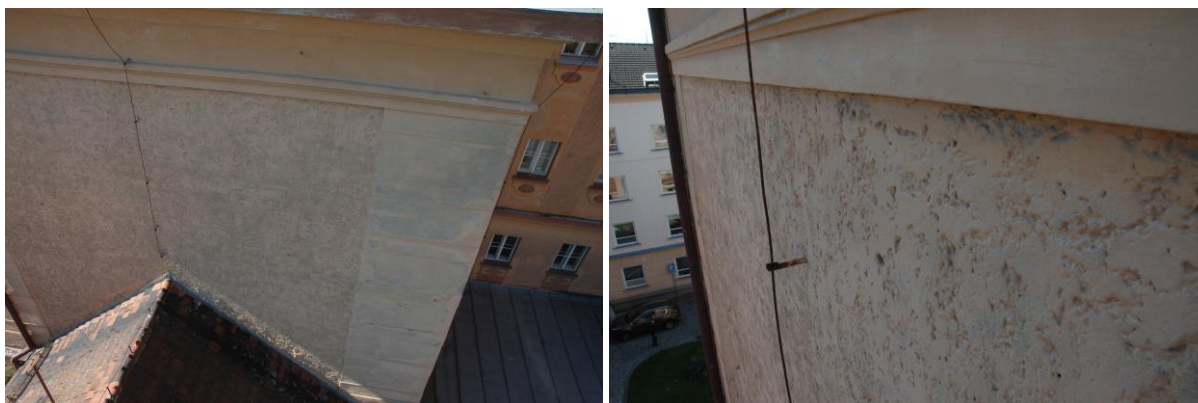
Plochy opatřené strukturovanou „utaženou- zahlazenou“ omítkou.
