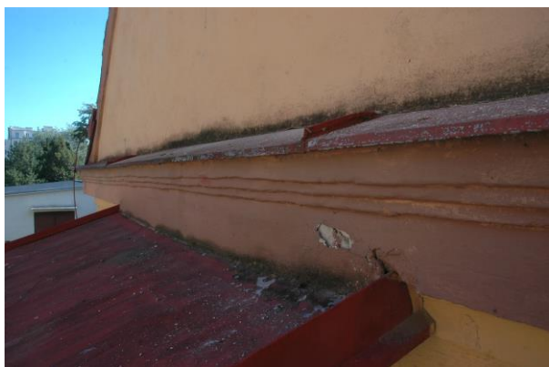
Zjednodušená profilace lemu štítu provedená z nové cementové omítky
