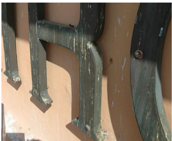
Detail liter zhotovených z Cu plechu
